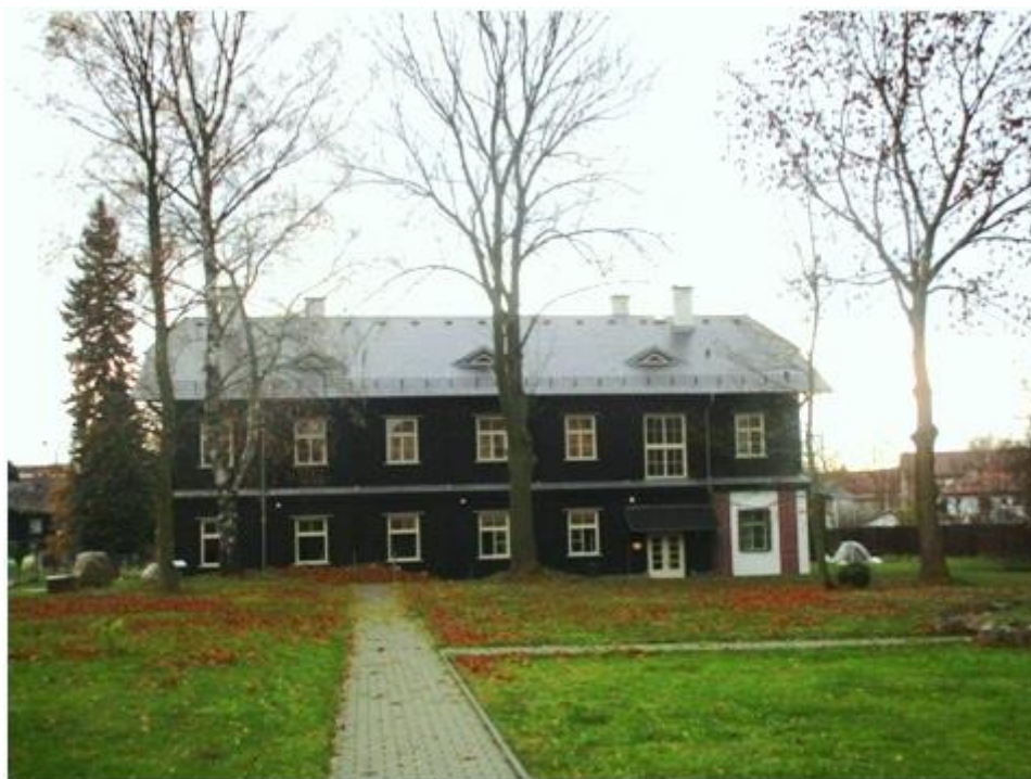
Obr. 89: Ubytovna ve Strašicích v bývalém kasárenském objektu Foto: Alena Matušková
