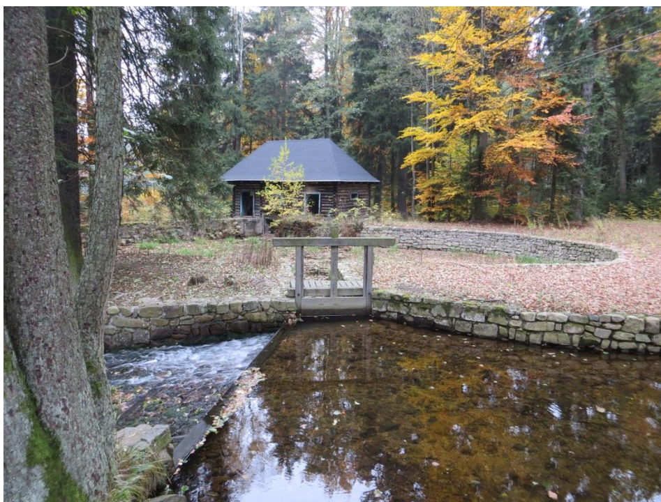
Obr. 22: Bývalý objekt malé vodní elektrárny pod soutokem Padrt'ského a Třítrubeckého potoka.
