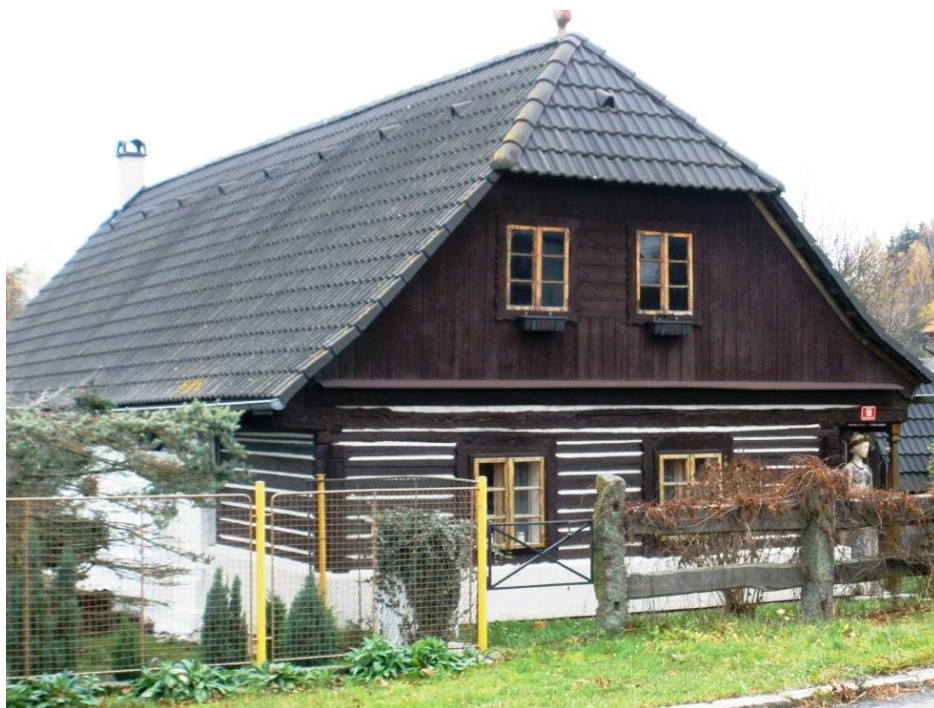
Obr. 120: Lidová architektura tvoří nedílnou součást hodnot krajinného rázu Brd a Podbrdská (Nové Mitrovce)
