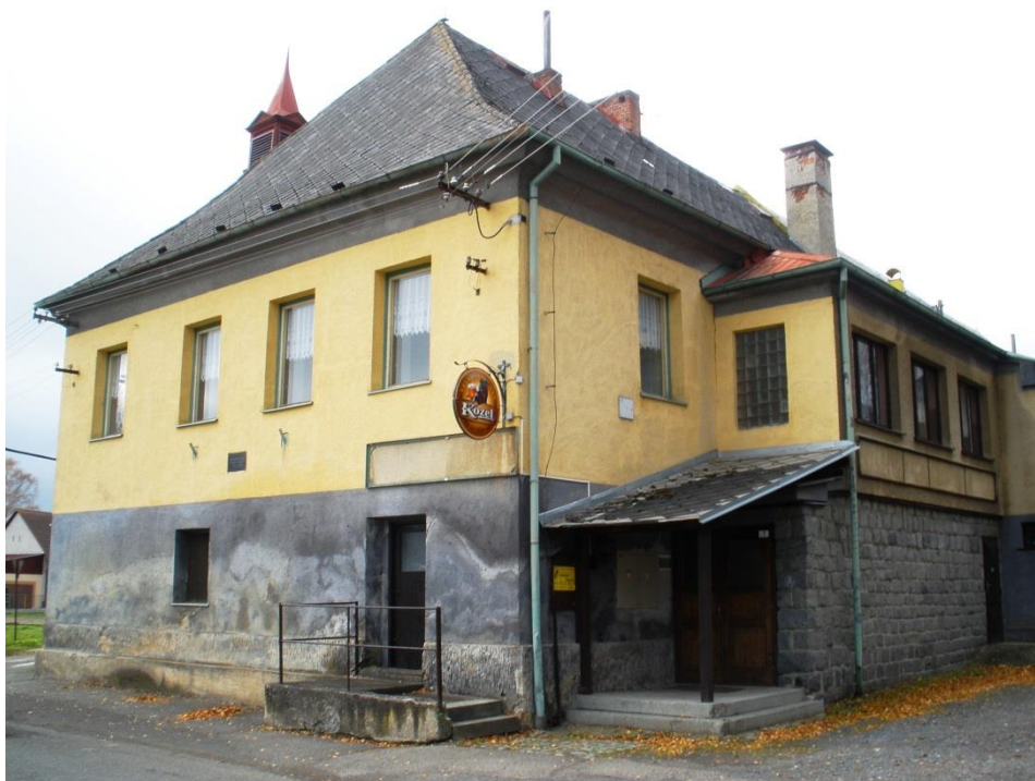
Obr. 126: Objekt plánovaný obcí jako centrum služeb cestovního ruchu ve Starém Smolivci Foto: Jan Kopp
